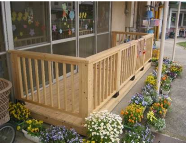
C デッキフェンス
